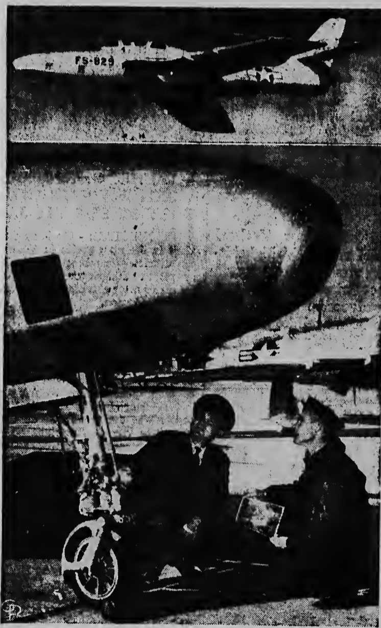
De Republic RF-84F Thunderflash, een straaljager met pijlvormige vleugels, zal door de Amerikaanse luchtmacht als fotovliegtuig worden gebruikt. Op de bovenste afbeelding ziet men het toestel tijdens een vlucht (650 mijl per uur), onder: een afbeelding van de neus met openingen voor fotocamera's en radar-toestellen.
